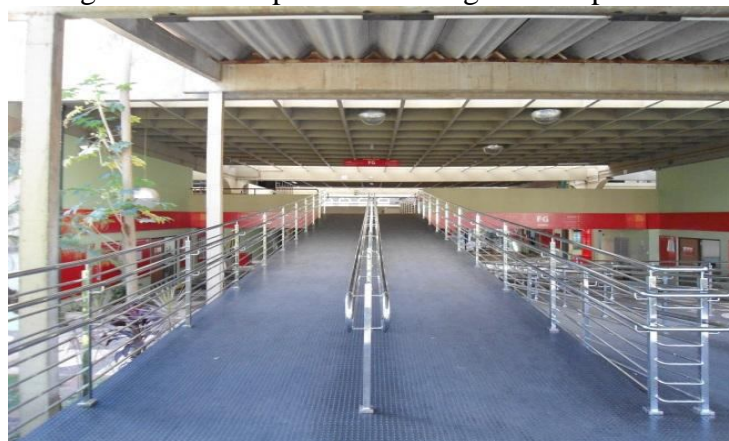
Figura 34 - Rampa de acesso e guarda-copo
