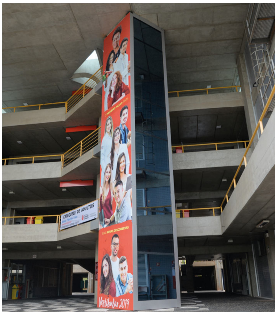
Figura 32 - Elevador de acesso aos blocos J e K
