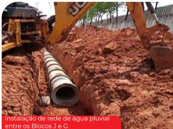
Instalação de rede de água pluvial entre os Blocos J e G
