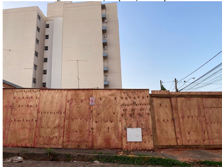
Figura 9 – Pichação após ação antrópica
