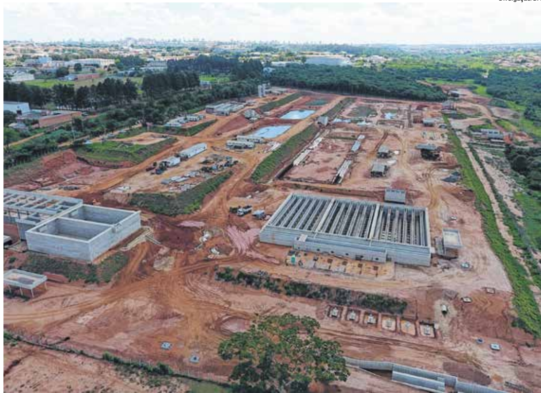
Gleba com vegetação nativa a ser adquirida pela prefeitura fica ao lado da Estação de Esgoto
