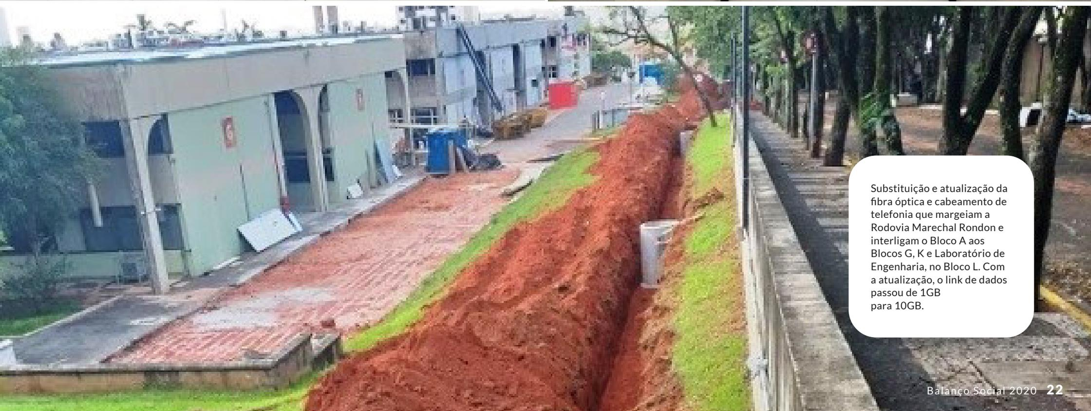
Substituição e atualização da fibra óptica e cabeamento de telefonia que margeiam a Rodovia Marechal Rondon e interligam o Bloco A aos Blocos G, K e Laboratório de Engenharia, no Bloco L. Com a atualização, o link de dados passou de 1GB para 10GB.
